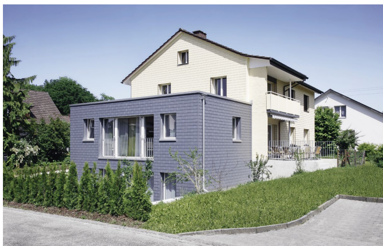
Die Station Viva ist harmonisch in das gehobene Einfamilienhaus-Quartier integriert.
