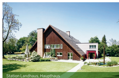
Station Landhaus, Haupthaus
