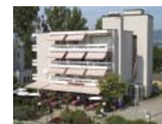
ROSENGARTEN, Gossau ZH Alters- und Pflegeheim www.rosengarten-gossau-zh.ch
